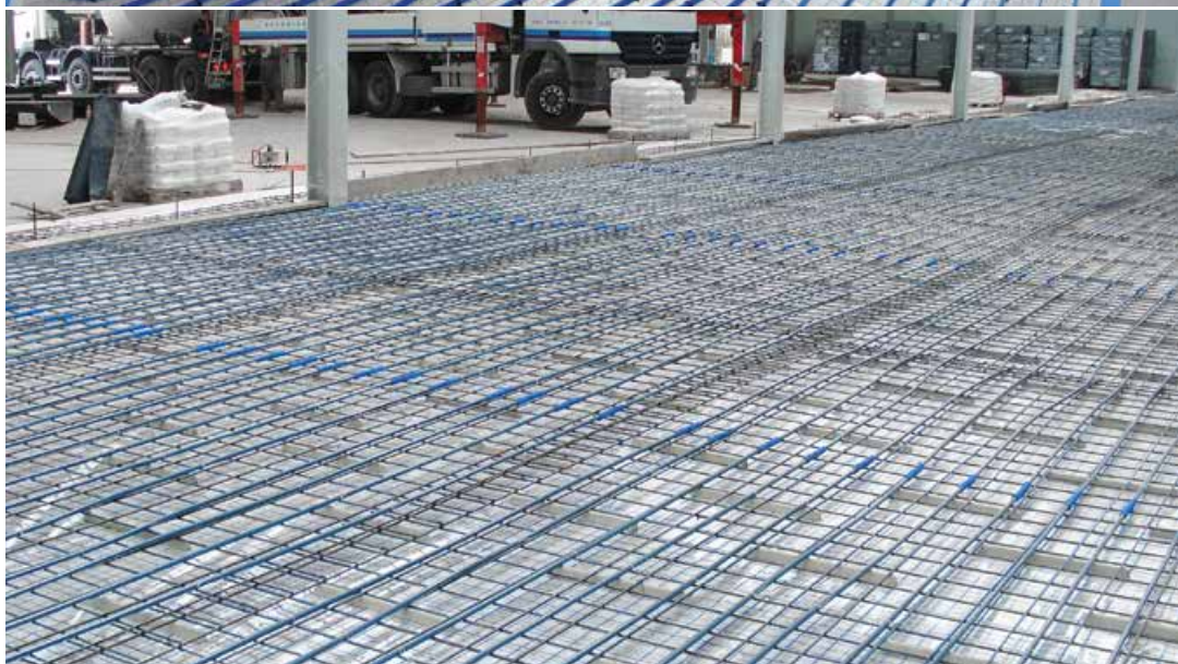
Obr. 4. Instalace podlahového topení ve skladové hale s využitím trubek blueFLOOR PERT a systému KAN-therm NET.
