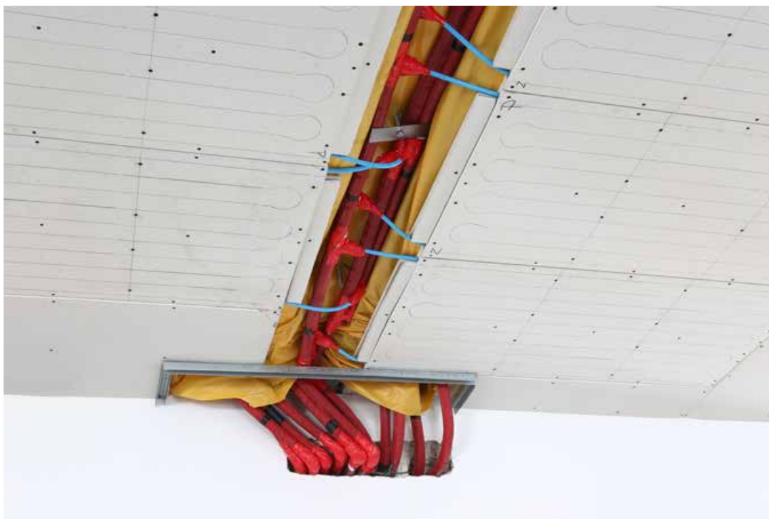
Obr. 6. Instalace stropního chlazení s využitím topných a chladících desek systému KAN-therm Wall.
