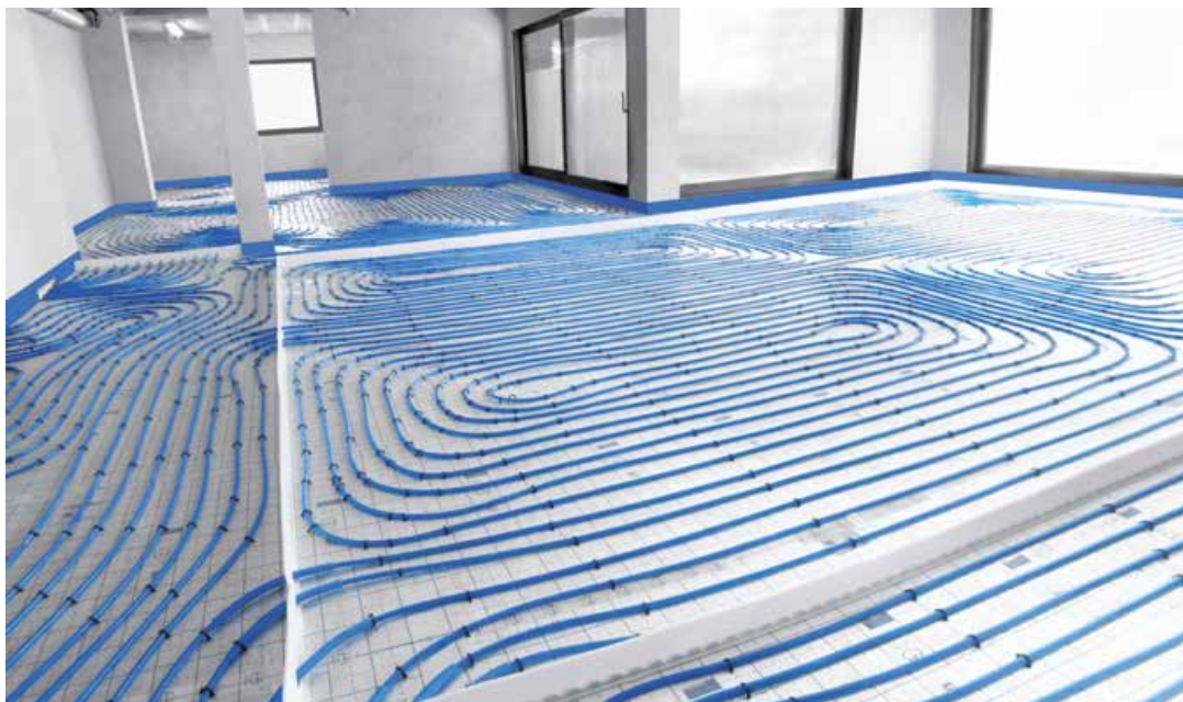
Obr. 25. Instalace podlahového topení/chlazení provedená v systému KAN-therm Tacker.
