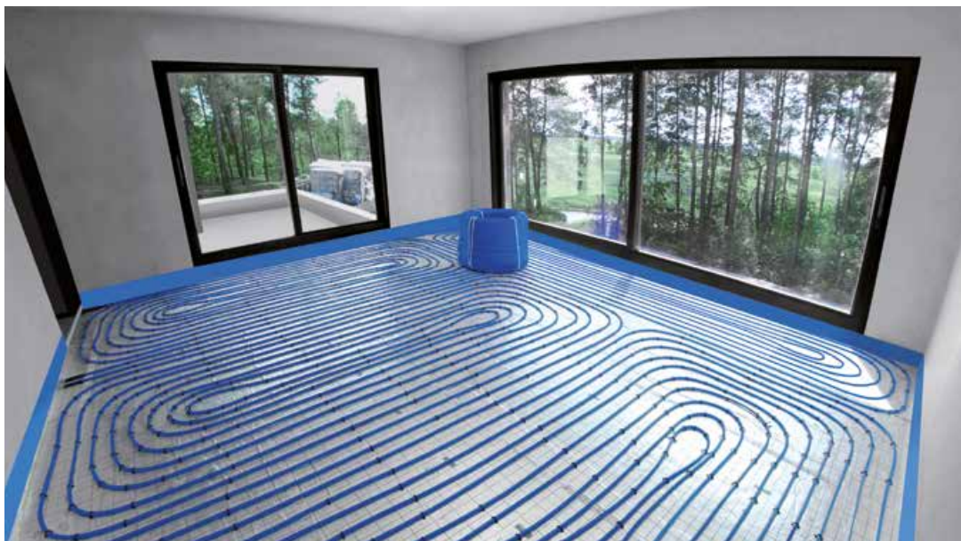
Obr. 3. Instalace podlahového topení v rodinném domě, s využitím trubek blueFLOOR PERT a systému KAN-therm Tacker.
