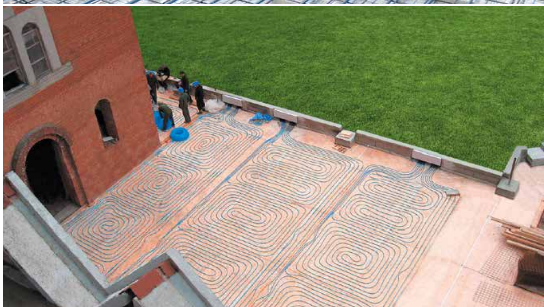
Obr. 5. Instalace venkovního vytápění terasy s využitím trubek blueFLOOR PERT systému KAN-therm.
