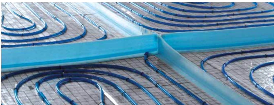
Obr. 14. Rozdělení topných polí dilatačními spárami
